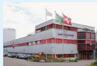
Usine de Niederuzwil
